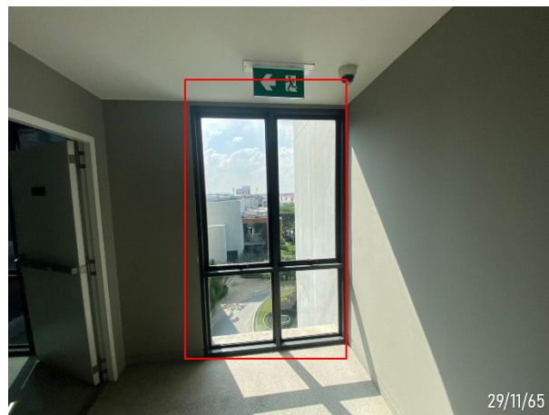
รูปที่ 2-22 ช่องเปิดระบายอากาศของอาคาร
