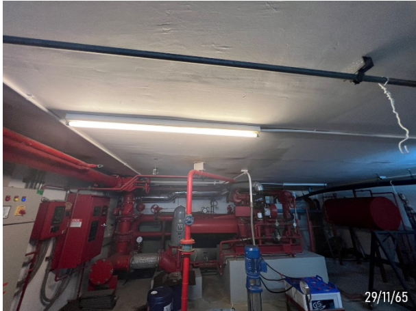
ระบบเครื่องสูบน้ำดับเพลิง (Fire Pump System)
